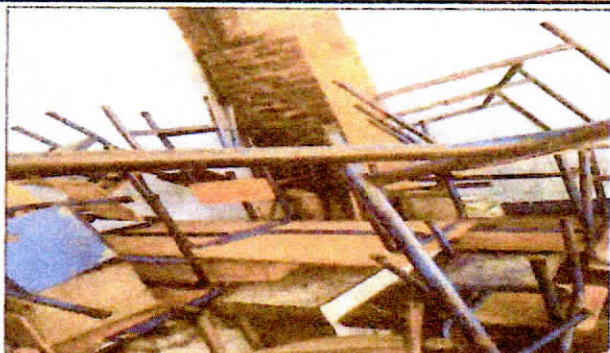
Foto 1: SUSTITUCION DE COCINA MEJORADA EN MAL ESTADO POR MESA DE CONCRETO.
